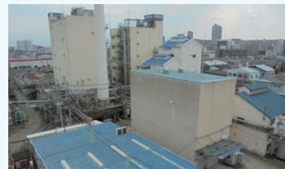
2015年7月 撤去工事着手前の工場風景
