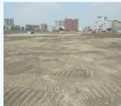
2017年6月 撤去工事が完了した全体風景
